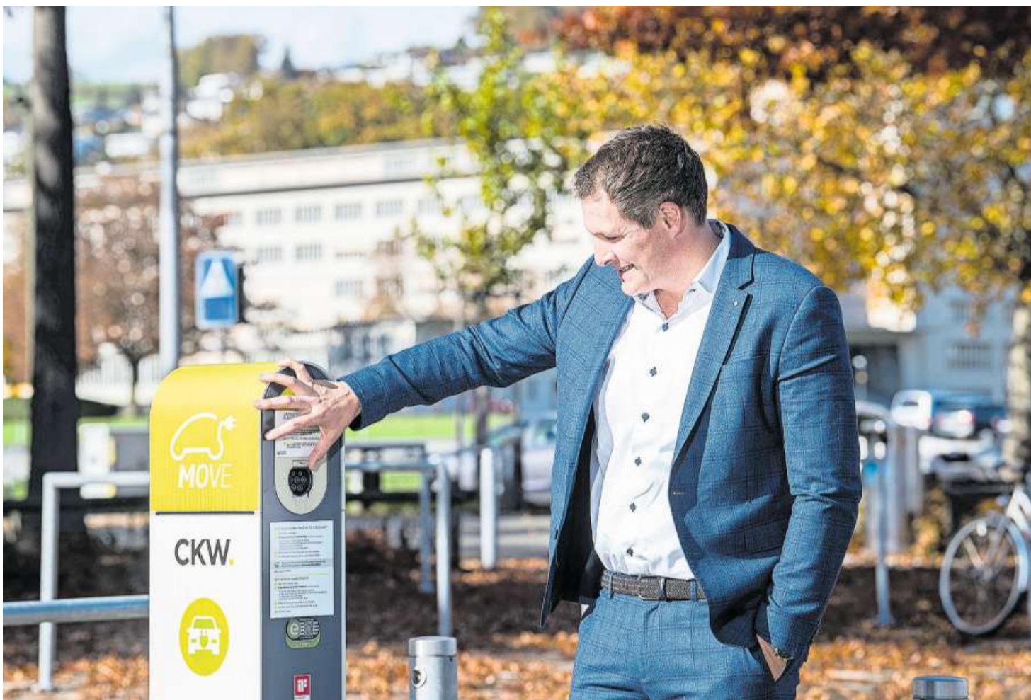
Thomas Meier bei einer Ladestation für Elektrofahrzeuge auf der Luzerner Allmend.
